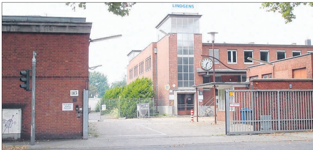
Die Zufahrt auf das Firmengelände sollen bald Anwohner und Besucher nutzen. (Foto: Himstedt)
