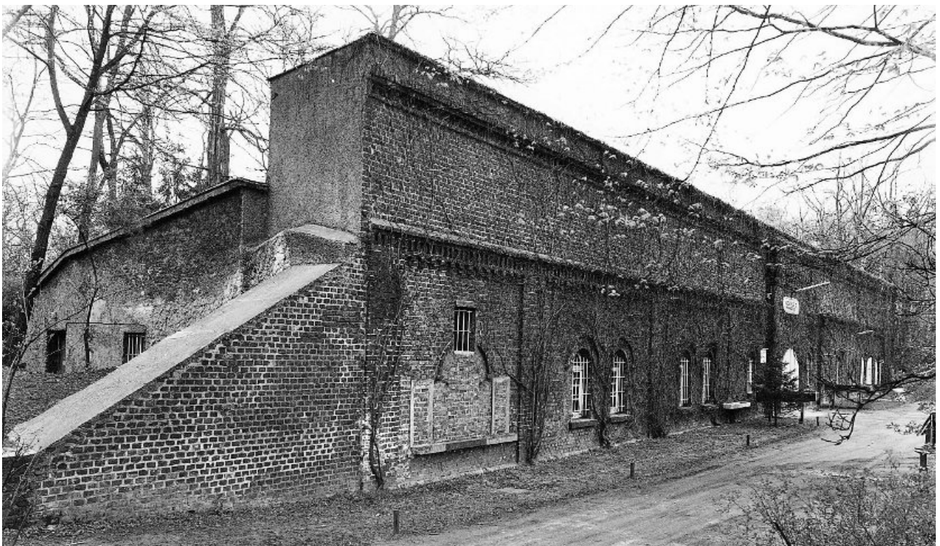
Abb. 1: Zwischenwerk IIIb. Ansicht der ehemaligen Kehlkasernen
