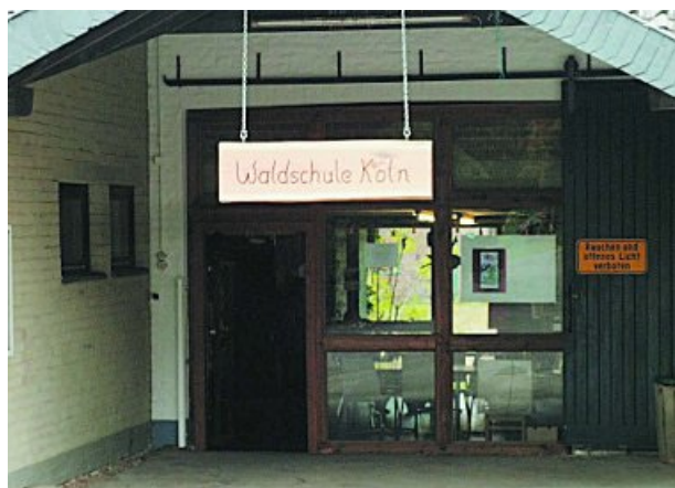
Abb. 6.: Eingangsbereich der Waldschule
