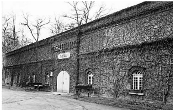
Abb. 4: Zwischenwerk IIIb. Ansicht der ehemaligen Kehlkasernen
