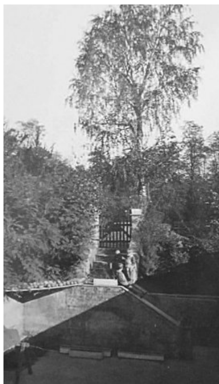
Abb. 11: Treppenanlage seitlich des Zwischenwerks IIIb
