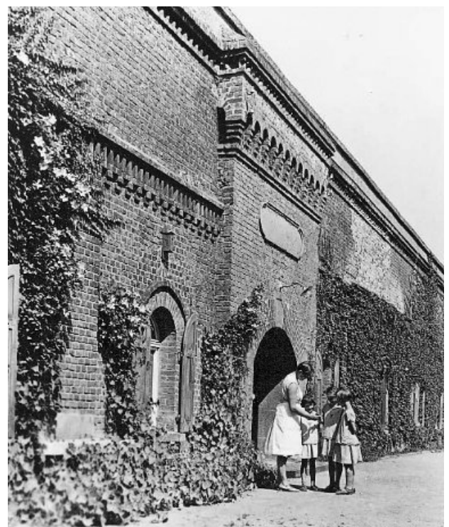
Abb. 6: Eingangsbereich Waldschule II
