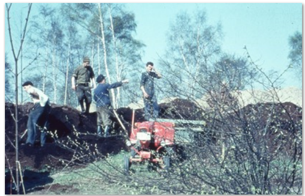
Arbeiter bei der Anlage des Forstbotanischen Gartens
