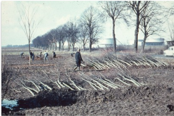
Anpflanzungen im Bereich von Industrieanlagen
